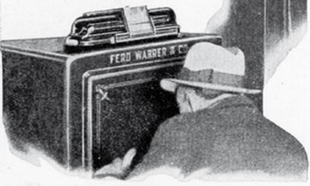
L'invention d'un homme de Chicago, un pistolet à gaz lacrymogène, dans le cercle, décharge quand la plaque avant du coffre-fort est entamée par le perceur de coffre, complétant le circuit électrique qui envoie l'alarme de police. La victime aveuglée est facilement capturée et emprisonnée.
